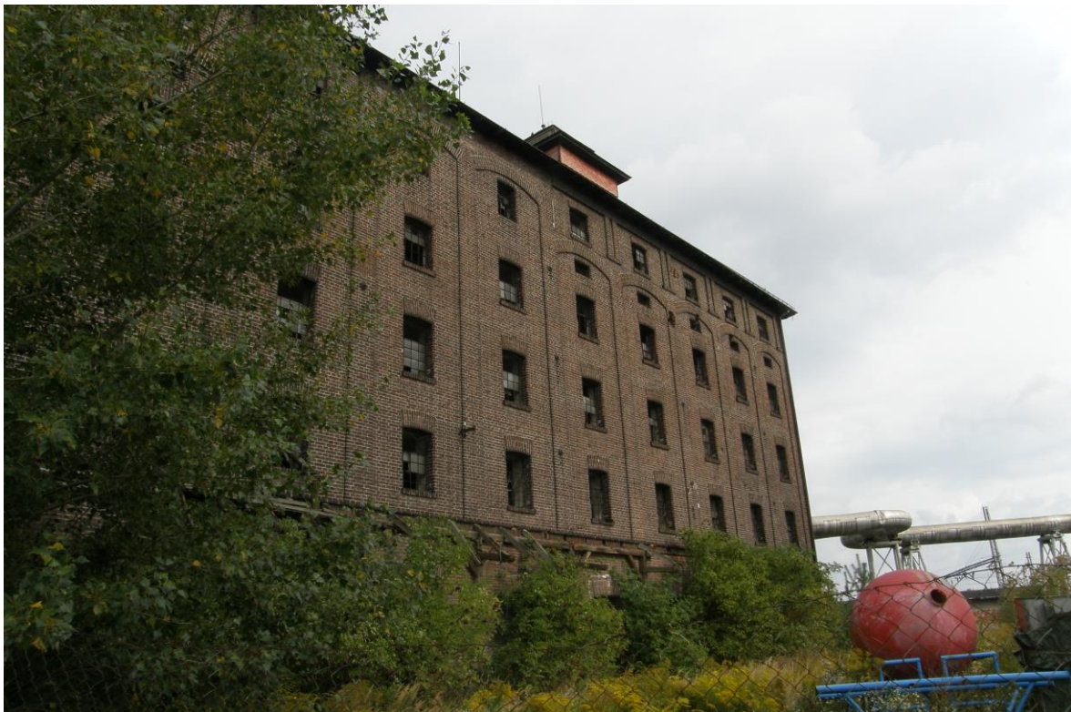
Obr. 1: stávající stav budovy
